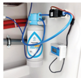
A kijelző felerősítési helyének példája
