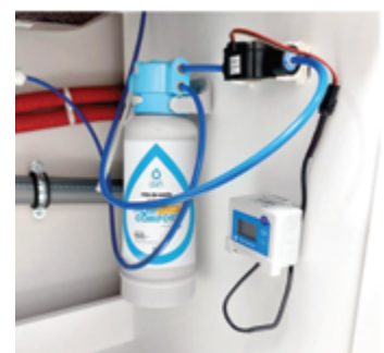
Beispiel für die Montage der Anzeige
