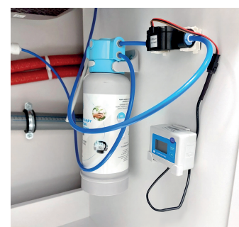
Przykładowe miejsce zamocowania wskaźnika
