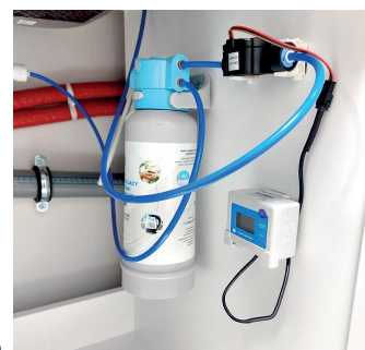
A kijelző felerősítési helyének példája
