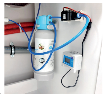
Beispiel für die Montage der Anzeige
